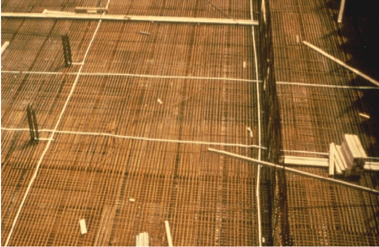
Temel topraklamada şeridin tesisi
