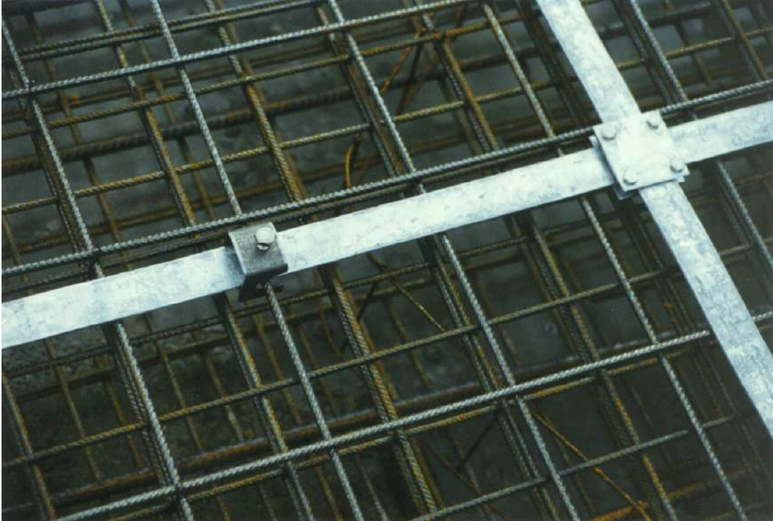
Çelik donatılı temel topraklayıcının üstten görünüşü
